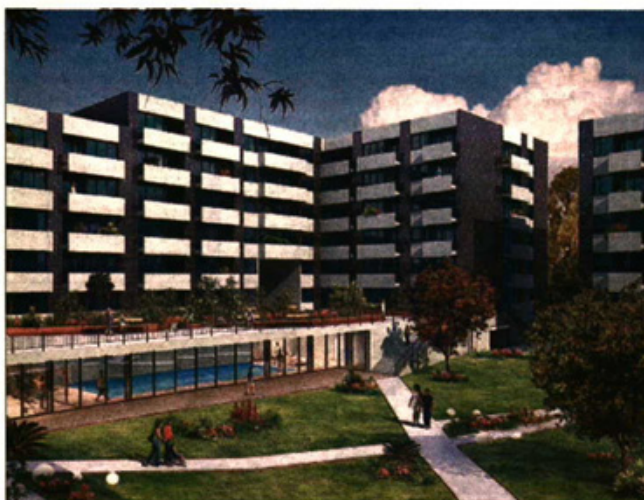
Empreendimento inclui 315 apartamentos | DE
